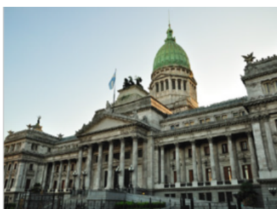
Edificio del Congreso, Buenos Aires
